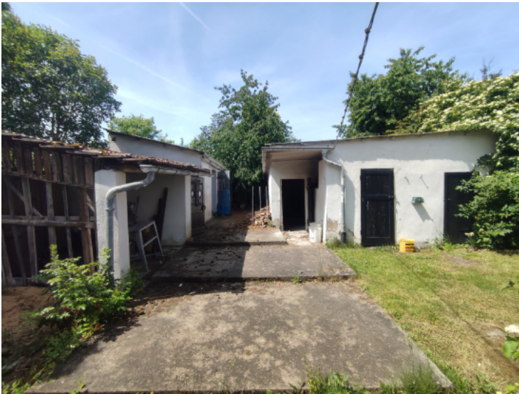
Hof mit Nebengebäuden, rechts Keller und Brunnenhaus
