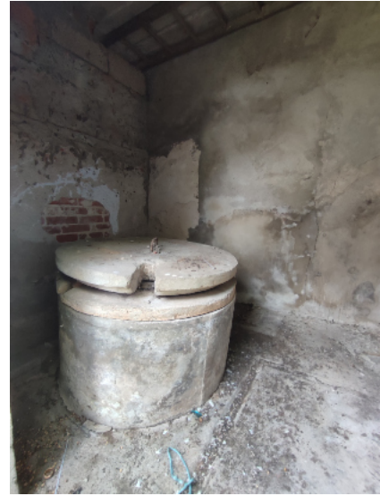
Brunnen im Nebengebäude
