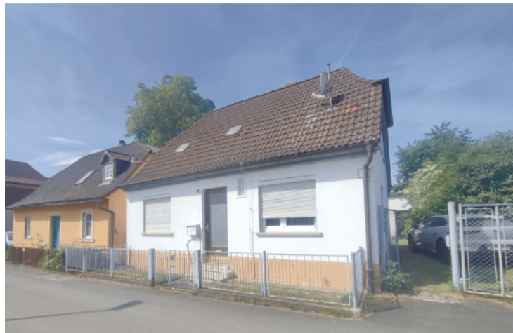
Torzufahrt zum Grundstück und den hofseitigen Nebengebäuden
