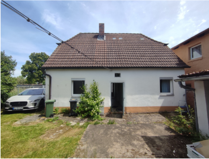
Rückwertige Ansicht mit Erschließung der Hofanlage
