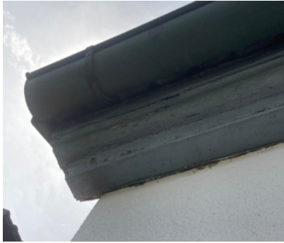
profiliertes, hölzernes Traufgesims
