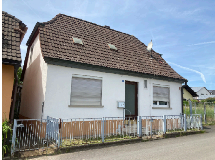
Ansicht der Hauptfassade mit zentraler Erschließung des Gebäudes
