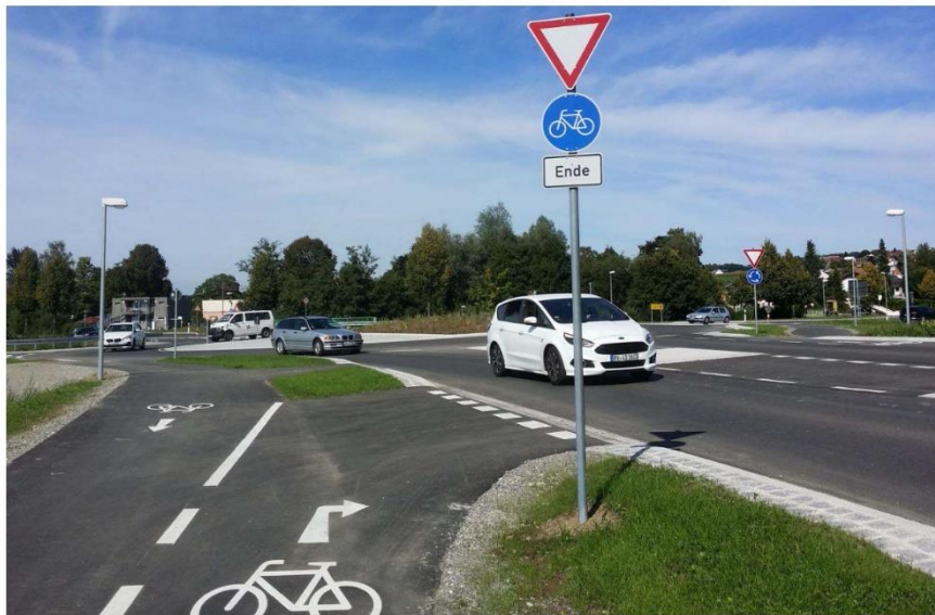
Bild 2: Höhengleiche Fahrbahnquerung eines Radweges [Quelle: topplan 2020]
